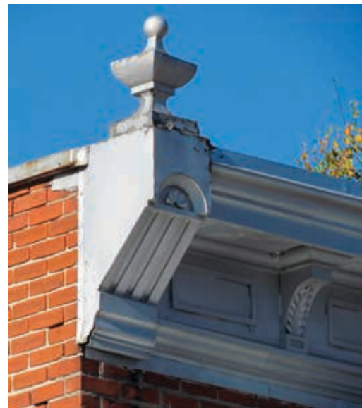
Console avec urne, et extrémité d'une corniche à consoles; tous ces éléments sont en tôle sur une structure de bois. 17-19, rue Saint-Lambert, Sainte-Thérèse.
