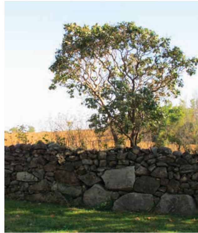
Muret de pierres sèches datant probablement de la première moitié du 20 e siècle. 208-210, chemin de la Côte Sud, Boisbriand.
