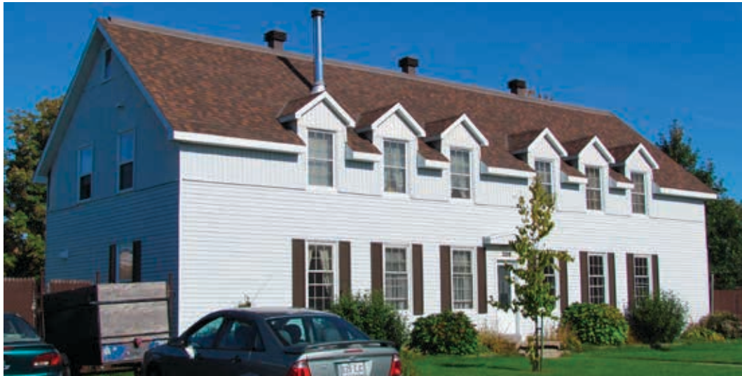
Édifice résidentiel multifamilial associé au Plan Bouchard. 205, rue du Général-Allard, Blainville.
