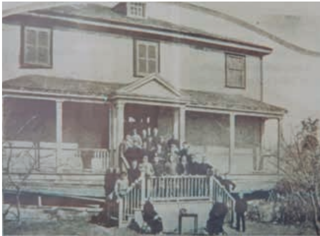
Le Castel Morris en 1882. Un crépi recouvre la pierre. On remarquera la lucarne sur le toit et la fenestration qui est complètement différente de celle d'aujourd'hui. SHGMI, C001 S2 SS1 D10. Photo n° 2758.8.
