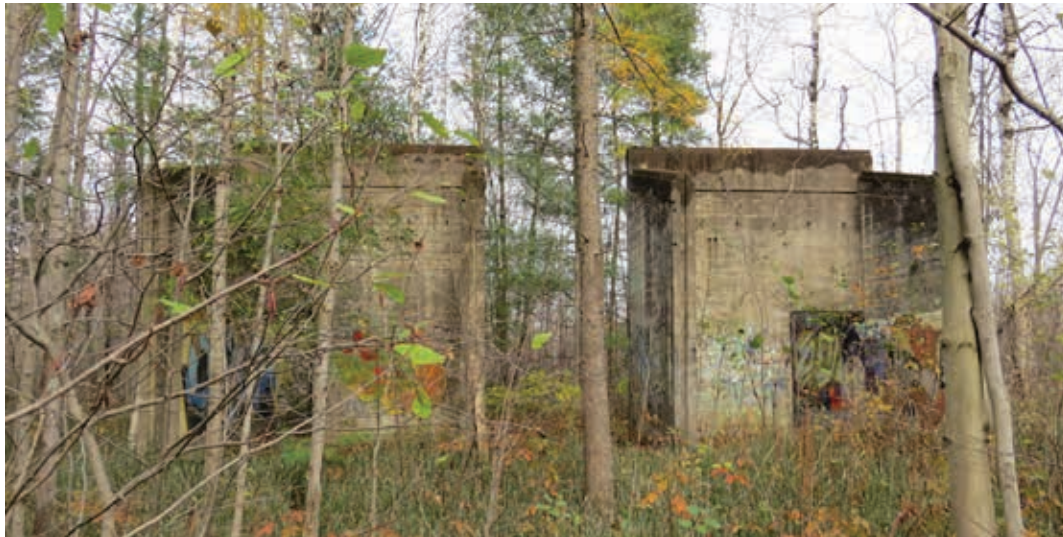
Structure 2, composée de deux bâtiments en béton placés l'un en face de l'autre.
