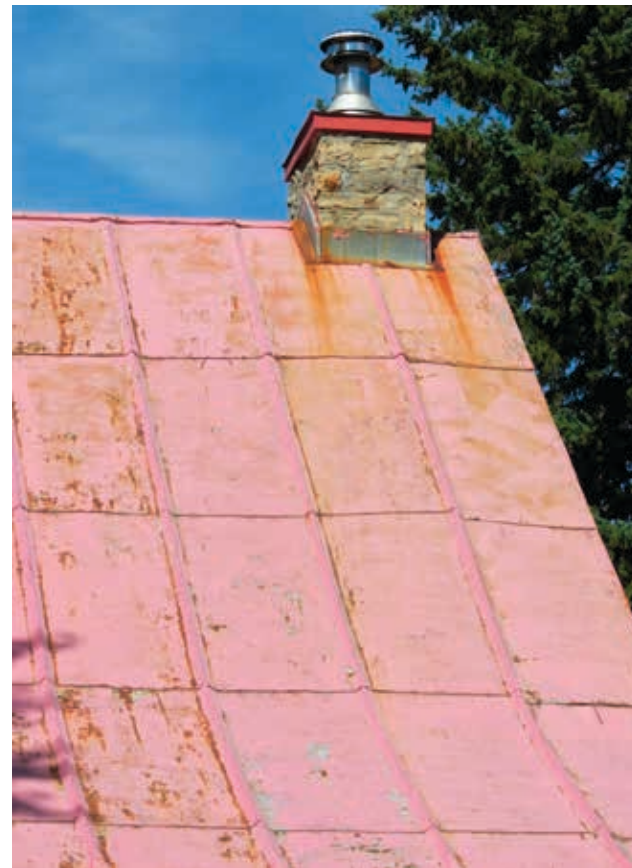
Détail d'un revêtement de tôle à baguettes. 118, rue Blainville Ouest, Sainte-Thérèse.
