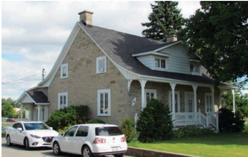
La maison Jean-Charles-Dubois, érigée en 1776, au 54, chemin de la Côte Sud, Boisbriand.
