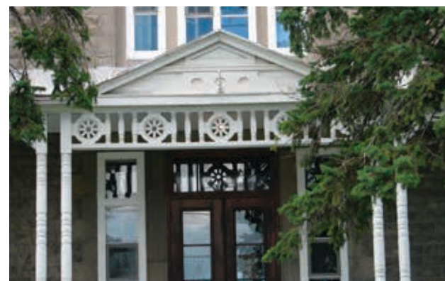
Fronton et lambrequin très ornementés de la façade principale du presbytère de Sainte-Anne-des-Plaines.
