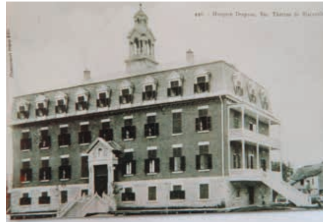
La façade nord de l'Hospice Drapeau vers 1907, érigé entre 1889 et 1992. 100, rue du Chanoine-Lionel-Groulx, Sainte-Thérèse. SHGMI, C001 S2 SS1 D5.
