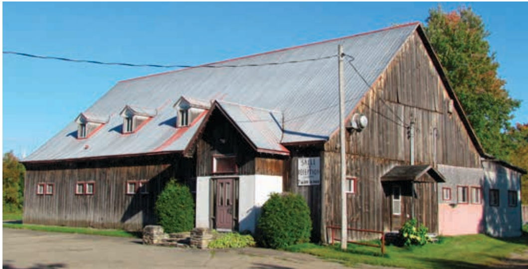
L'un des bâtiments secondaires ayant fait l'objet d'une fiche d'inventaire, une grange-étable au 223, chemin de la Côte Sud à Boisbriand.
