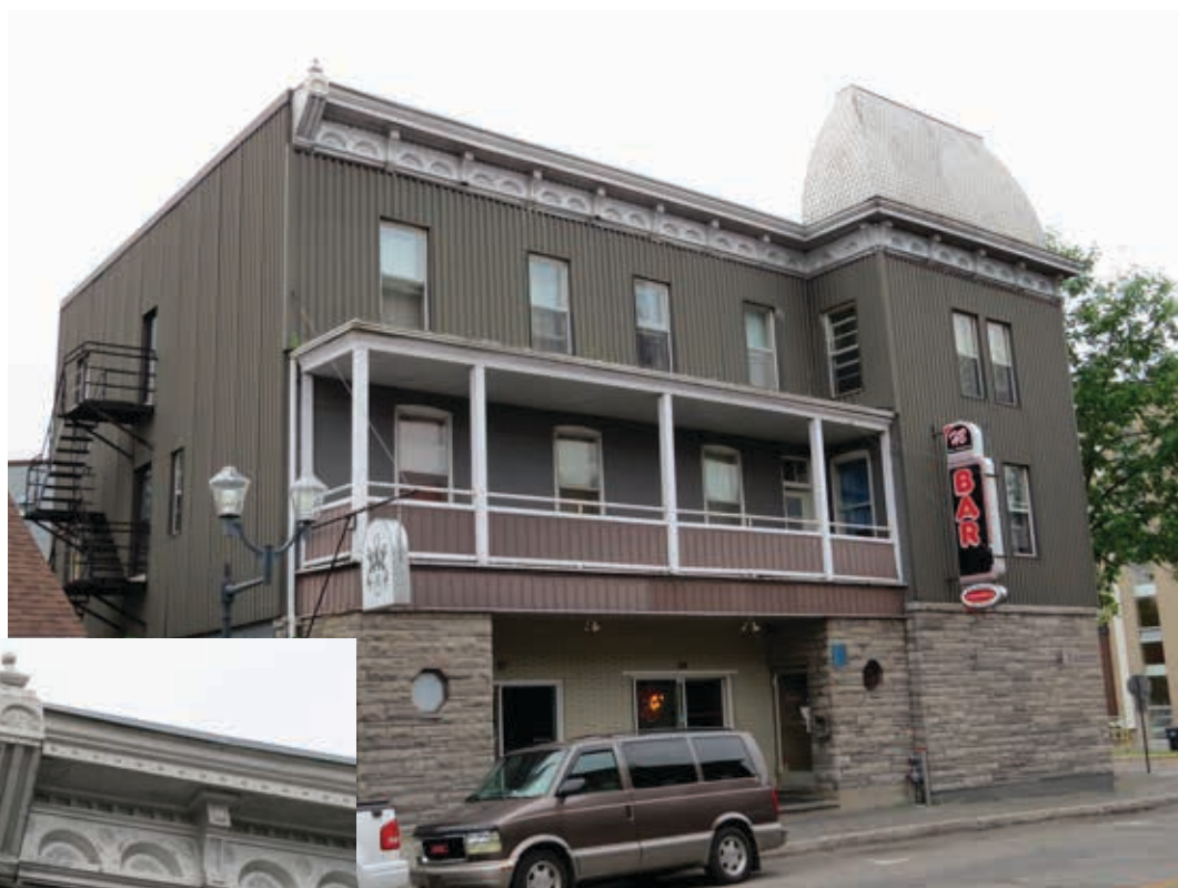
L'Hôtel Blainville en 2014. Une tôle profilée et un matériau qui imite la pierre recouvrent désormais la brique d'origine. Les colonnes tournées, les aisseliers et le garde-corps d'origine sont aujourd'hui disparus. Heureusement, l'imposante corniche métallique (en médaillon), à motifs embossés, est encore avantageusement préservée. 27-29, rue Blainville Ouest.
