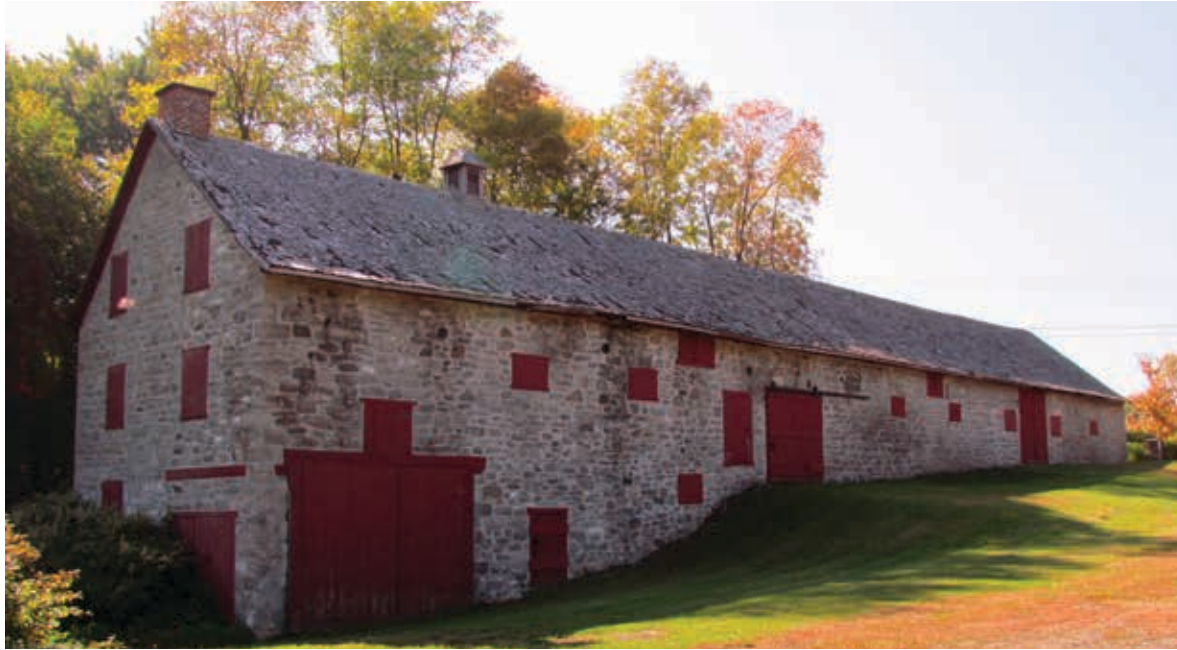
Grange-étable en pierre de la maison Garth, construite dans la dernière moitié du 19 e siècle, un genre de bâtiment extrêmement rare au Québec. 100, chemin de la Grande-Côte, Lorraine.
