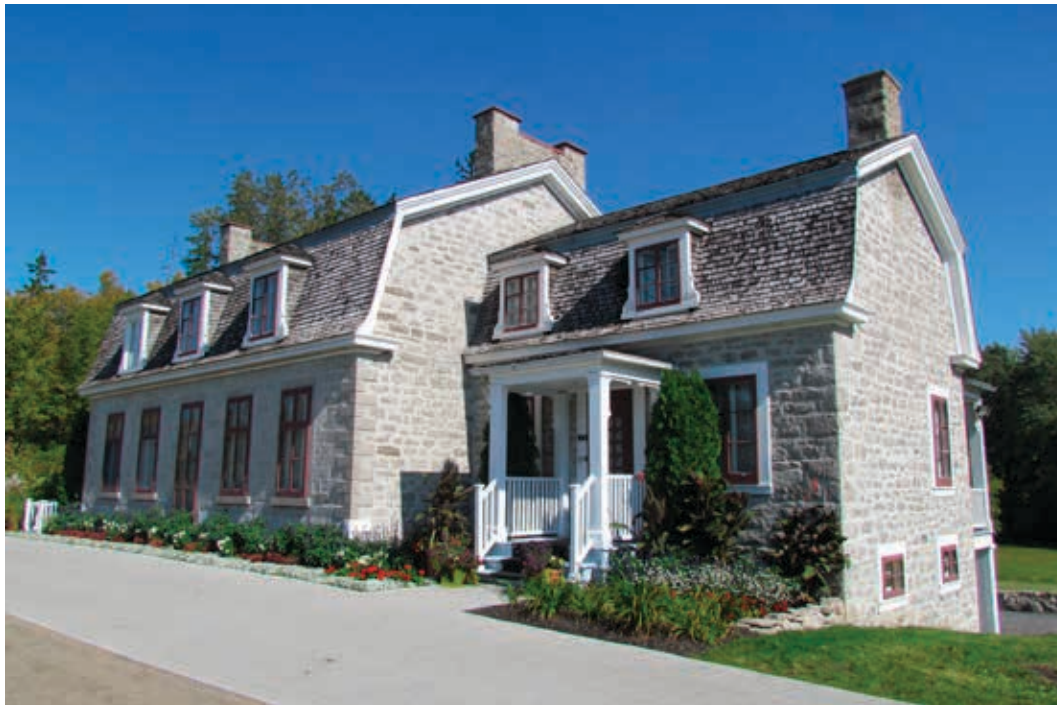
La maison Garth aujourd'hui. L'édifice a été fort bien restauré et se rapproche de son état d'origine. 100, chemin de la Grande-Côte, Lorraine.
