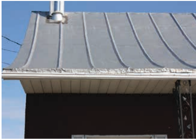
Tôle à baguettes. 205, 2 e Avenue, Sainte-Anne-des-Plaines.
